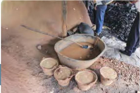
การอาบน้ำเตาโดยใช้ดิน ผสมน้ำลูบไล่ให้ทั่วทั้งเตา
